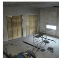
Die Fahrzeughalle hat eine Deckenhöhe von rund sieben Metern, weist vier Stellplätze vor und könnte nach Bedarf erweitert werden.
